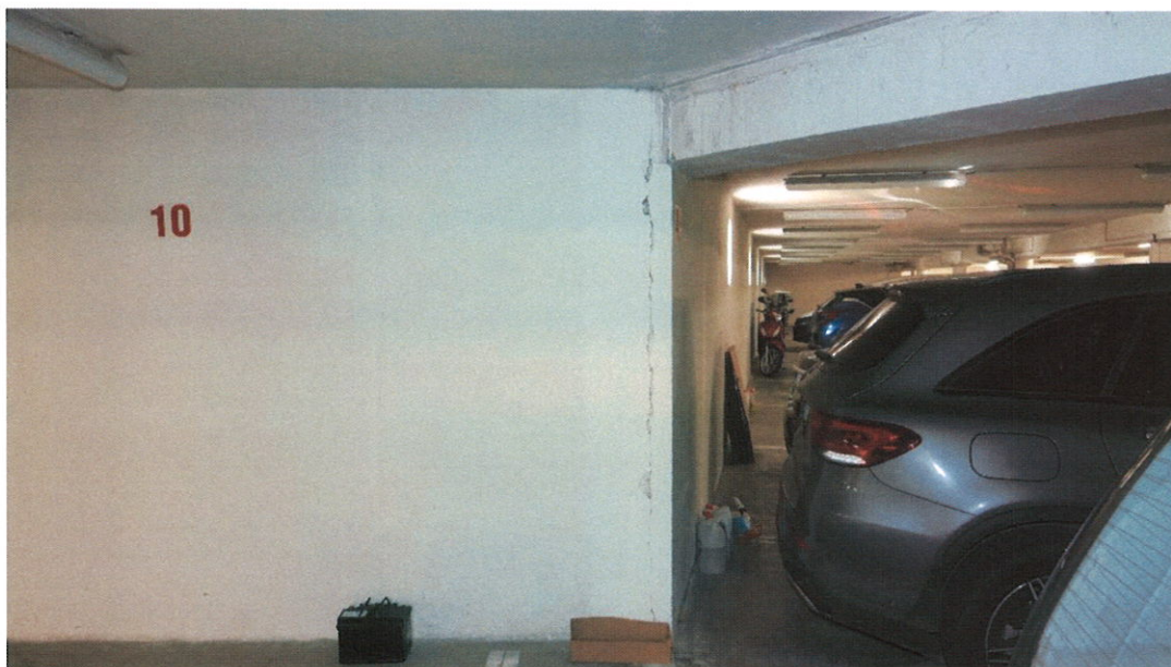
Obr. 7 Projev dilatačních pohybů ve stěně na levé straně podélného průvlaku
